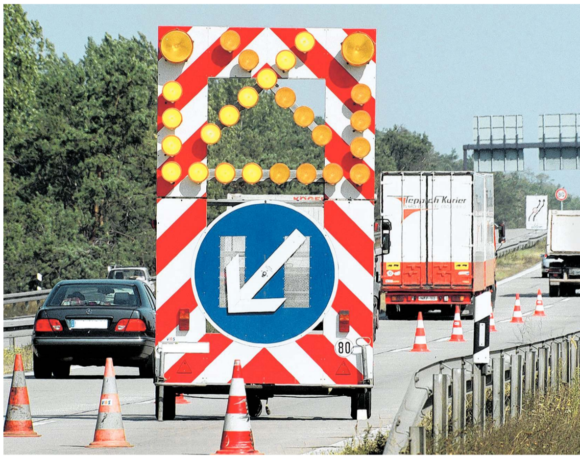
Baustellen sind ein alltägliches Bild auf Autobahnen im Land: eine optimale Sanierungsstrategie könnte ihre Zahl verringern. FOTO: DPA
